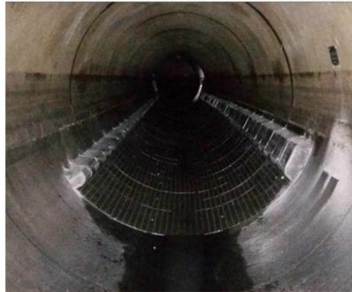
Abb. 6: Abwasserwärmetauscher im Kanal
