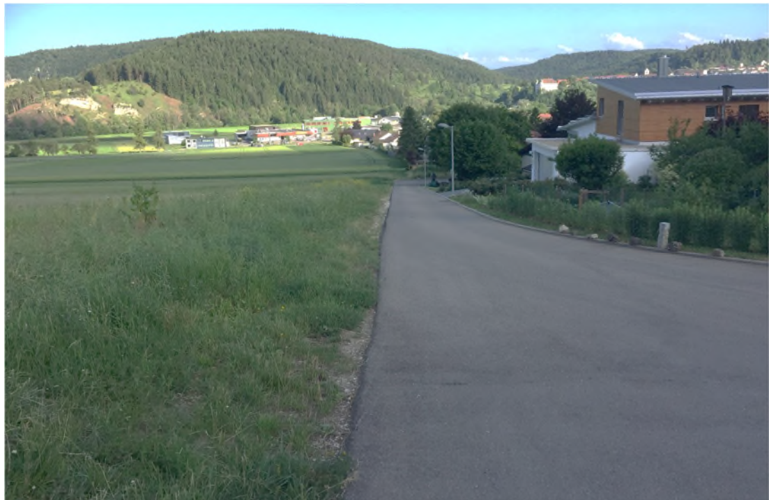
Abb. Erschließungsweg 1 – Bebauungsplan „Mühlensch“ - Blick von der Panoramastraße nach Süden
